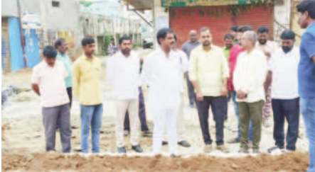
పనులను పరిశీలిస్తున్న ఎమ్మెల్యే మర్రి జనార్దన్ రెడ్డి
